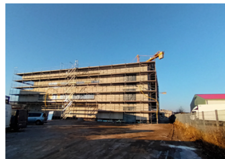
Ansicht des Rohbaus des FTZ von der Straßenseite
