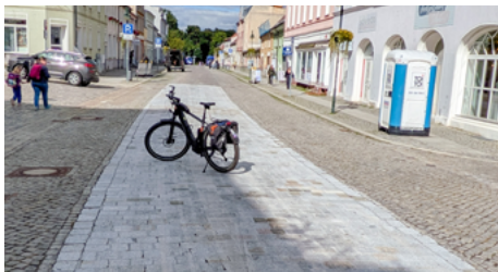
Durch das Präzisionsschleifen ist das Pflaster in der Großen Straße nun ebener und besser befahrbar.
