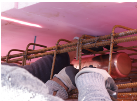
Die Zeitkapsel wurde im Fundament des künftigen Lehrerzimmers einbetoniert
