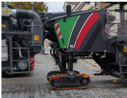
Mit diamantbesetzten Schleifscheiben wurde das Pflaster millimetergenau abgetragen. Foto: T. Deuse
